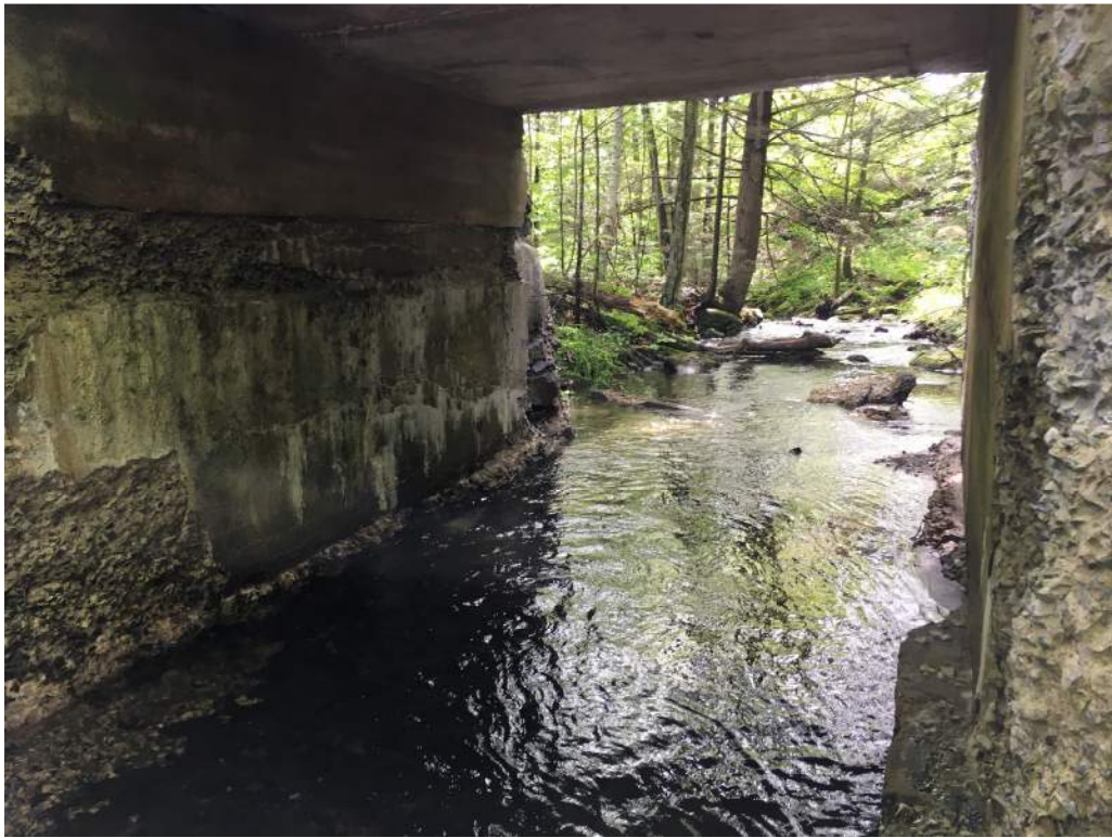
iv. Culvert Outlet:
